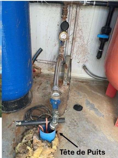
Disconnection avec l'eau du réseau assurée manuellement en débranchant le tuyau
