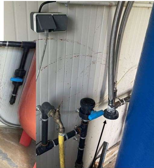
Disconnection avec l'eau du réseau assurée manuellement en débranchant le tuyau
